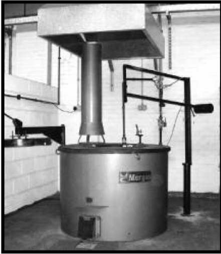
Fig.22 - Pirómetro montado en estructura marca Morgan, posicionado dentro del crisol.
